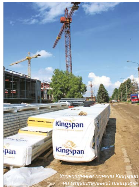
Нарушение правил хранения панелей приводит к их деформации, изменению геометрии и разрушению слоя утеплителя
